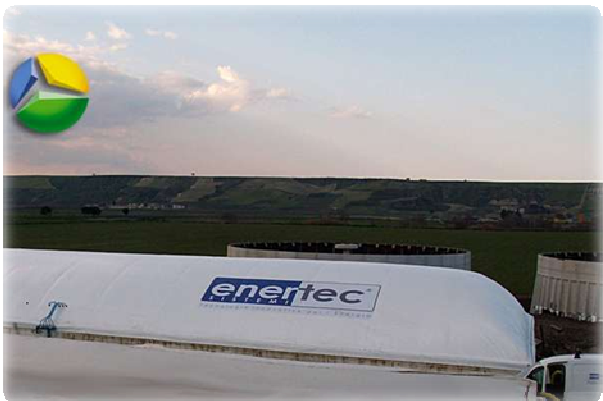
Digestore anaerobico a canale
